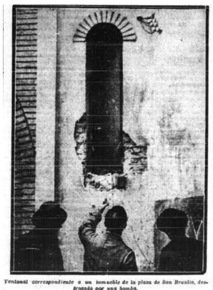
Ventana correspondiente a un inmueble de la plaza de San Braulio, destruido por una bomba.
