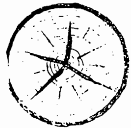
FIG. 9.5.—Grietas o pata de gallina.
